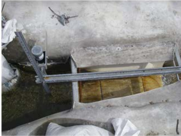
Vue en plan Règle fixée au centre du canal d'approche et au point de mesure d'un canal Palmer-Bowls
